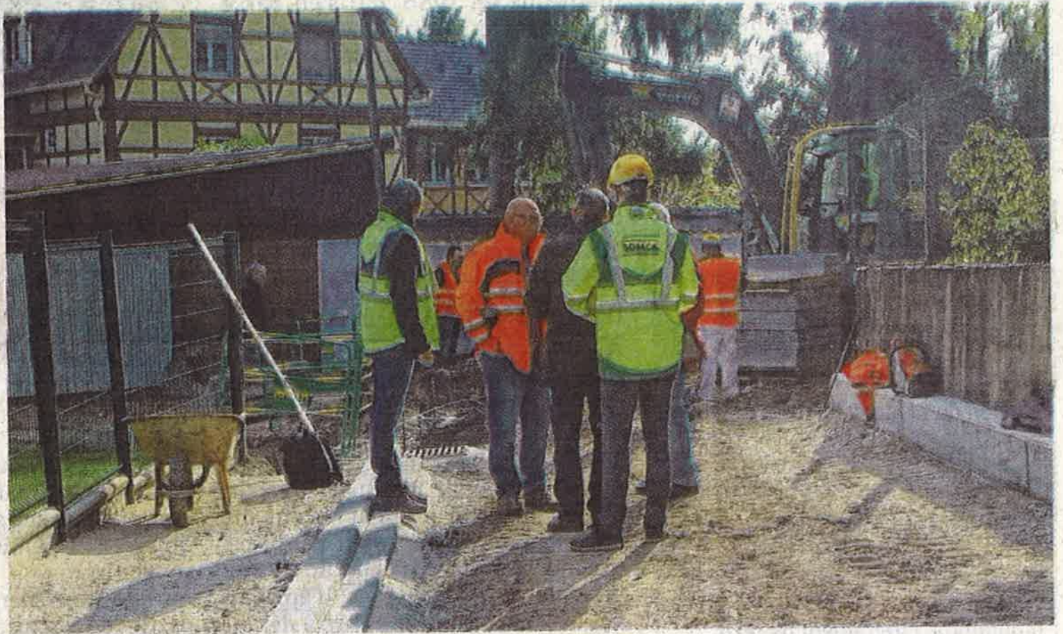
Des gaines ont été posées en prévision de la fibre optique. PHOTO DINA
