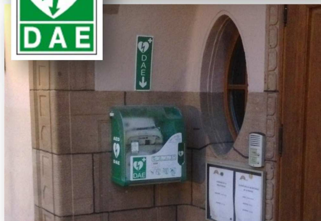
Le défibrillateur installé en façade de la Mairie
